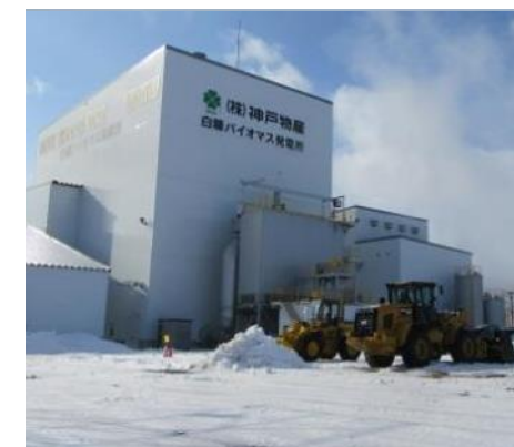
自社木質バイオマス発電所
